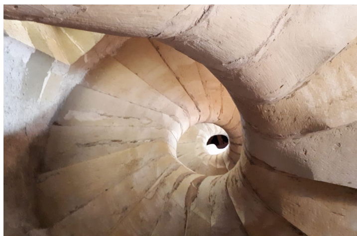
10 septembre : sortie des retraités, escalier du Château de Montrottier
